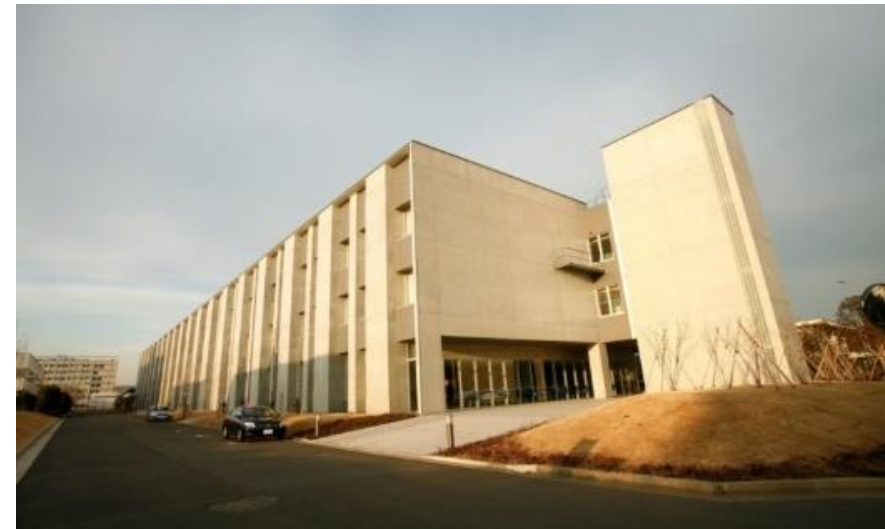
@東京ガストレーニングセンター
